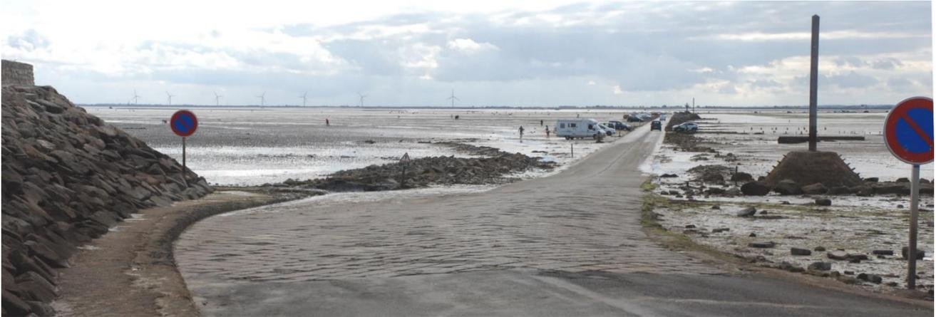
*Figure 51 : Passage du Gois en Vendée : digue, route, balises et refuges existent depuis la fin du XVIII<sup>e</sup> siècle (dans d'autres matériaux), la route a été surélevée plusieurs fois puis macadamisée dans les années 1920, signalisation routière et stationnement des véhicules sur la plage à marée basse existent depuis des décennies, le parc éolien de Bouin, au fond de la baie, est en fonctionnement depuis 2003*
