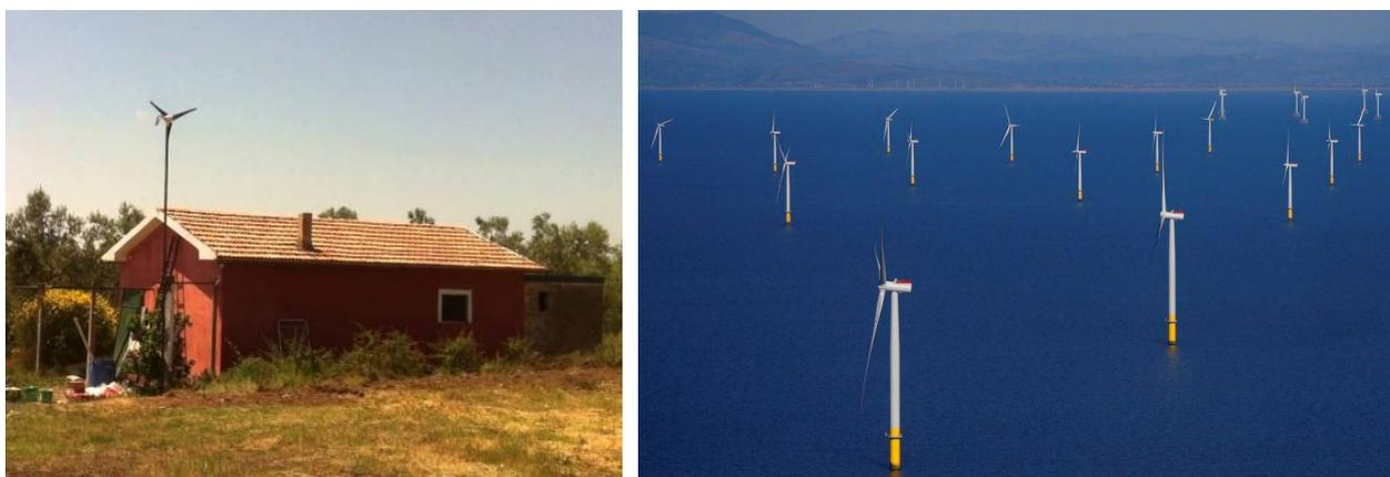
Figure 2 : Éolienne en site isolé, Canino, Italie (600 W), et parc éolien offshore Walney Extension, Royaume-Uni, (659 MW avec 40 MHI-Vestas de 8,25 MW et 47 Siemens Gamesa de 7 MW)), sources [8] [9]
