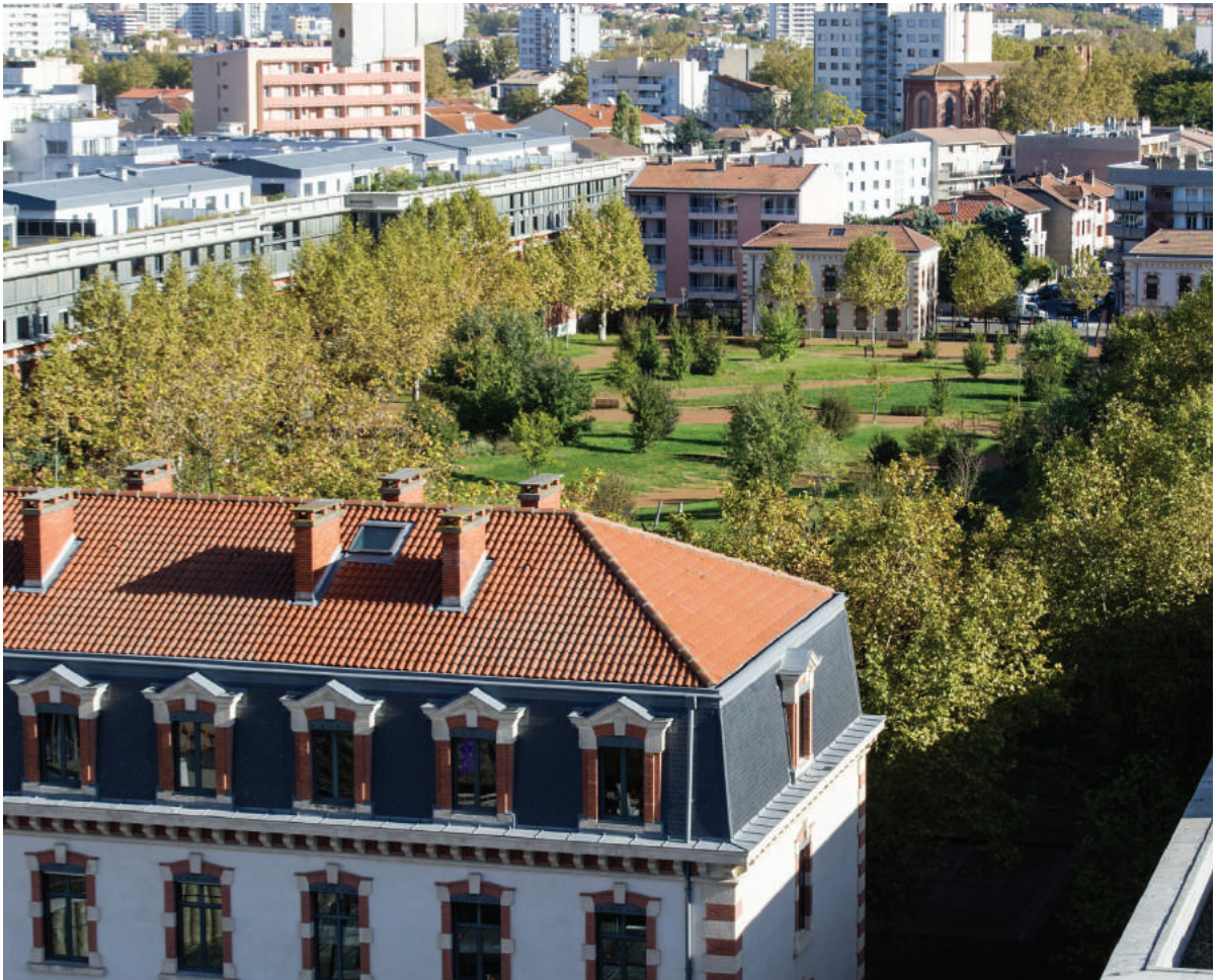
La caserne Niel, opération de renouvellement
