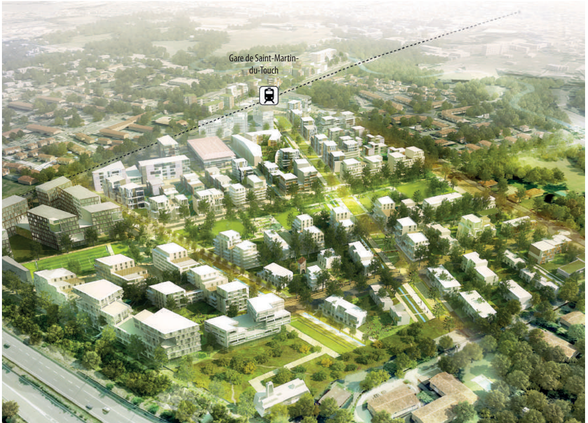
Le nouveau quartier de Saint-Martin-du-Touch
