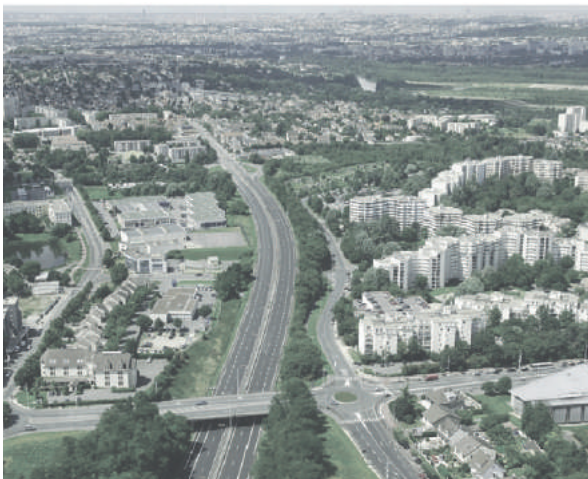
Marne-la-Vallée – ex Voirie Primaire Nord aujourd'hui - autoroute A199
