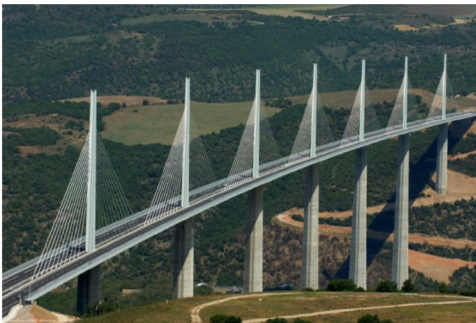
Viaduc de Millau
